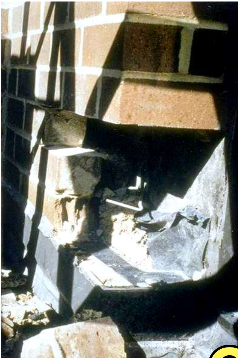
Mortar droppings
