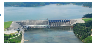
R. B. Russell Powerhouse
