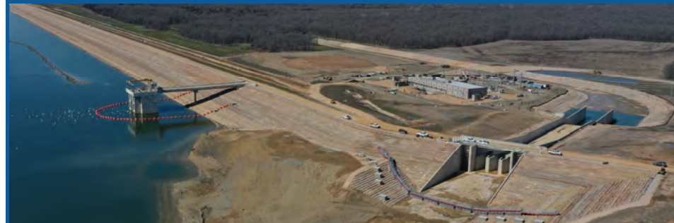
NTMWD - Bois d'Arc Dam & Reservoir
